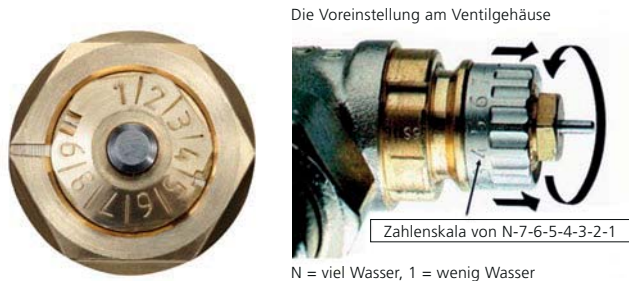
Abb. 1: Voreinstellung eines Heizkörperventils, Bildquelle: Oventrop GmbH und Danfoss AG
